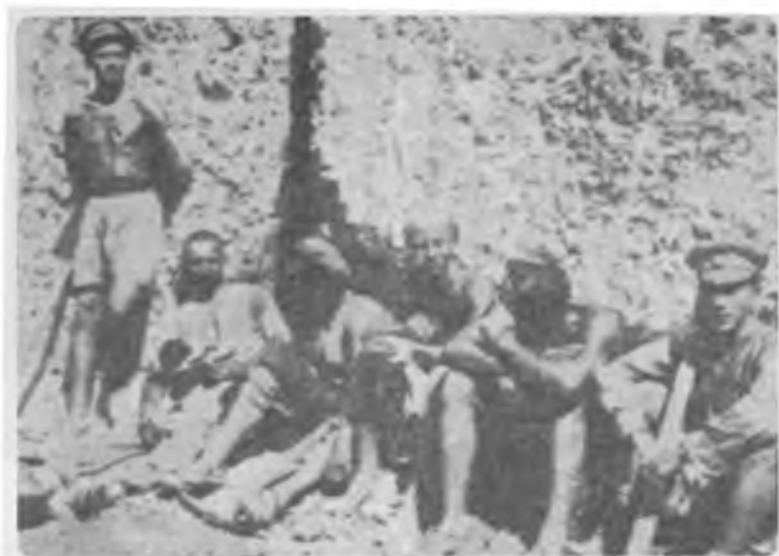
...На земляных работах
